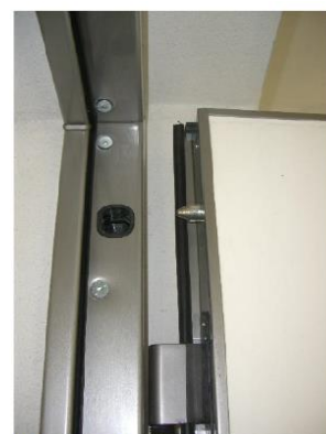
Fig. 5 - Posa di guarnizioni
